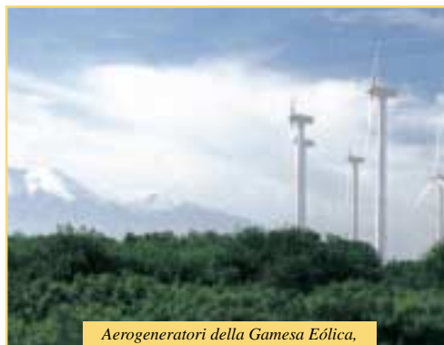
Aerogeneratori della Gamesa Eólica, Sito eolico di BORJA (Aragona)
