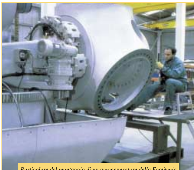
Particolare del montaggio di un aerogeneratore della Ecotècnia
